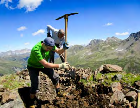
Das Fundament fürs Kreuz wird ausgehoben.
