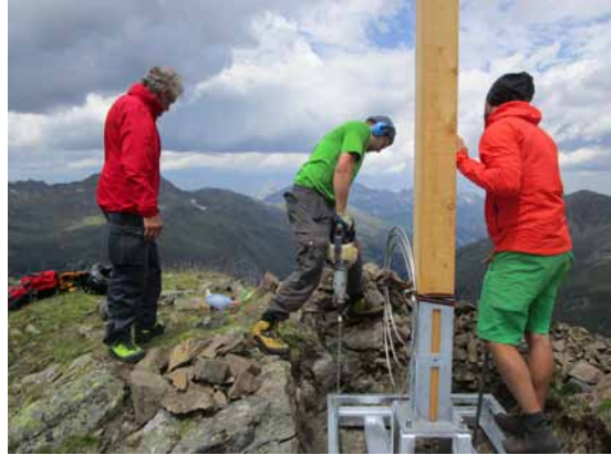
Oben: Punktlandung Unten: Befestigung im „Schotter“
